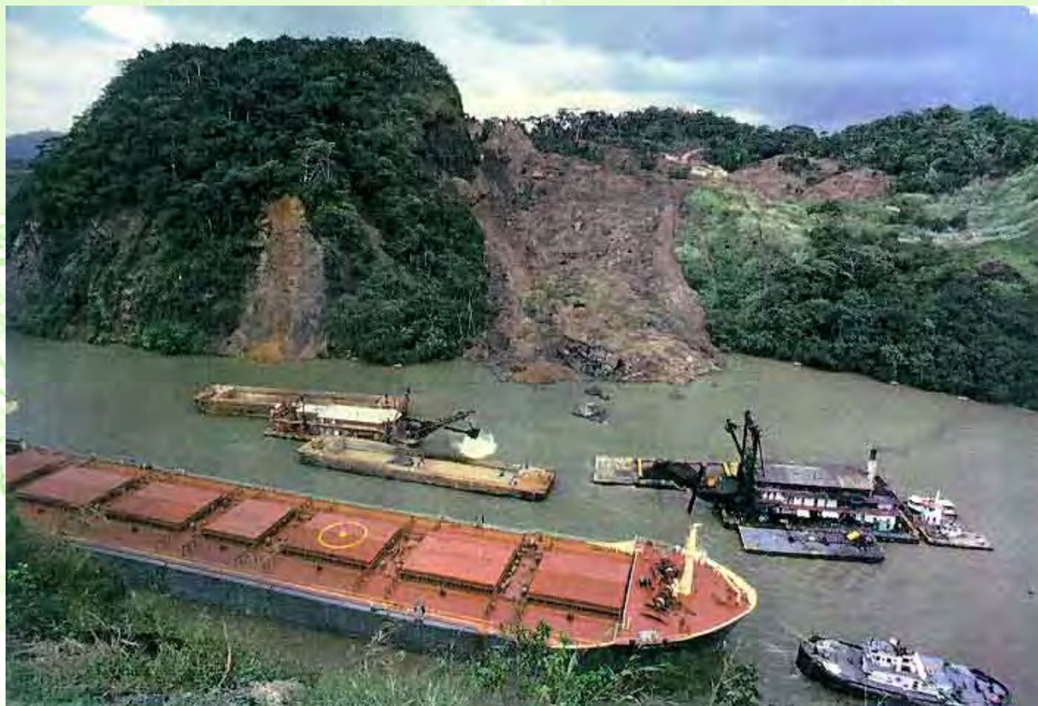
Работы по очистке русла канала от оползня
