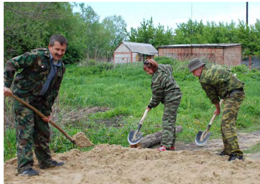
Строительство моста через реку Ржавка
