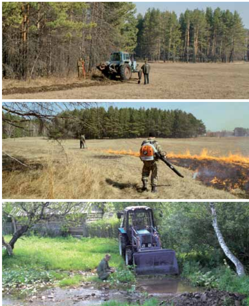
Рис. 5.1. Некоторые виды противопожарных профилактических мероприятий. Верхний снимок – создание противопожарной канавы (минполосы), средний – подготовка опорной полосы методом отжига, нижний – создание пожарного водоема (верхнее и среднее фото – А.В. Брюханов, нижнее – пресс-центр ГПЗ «Тигирекский»)
