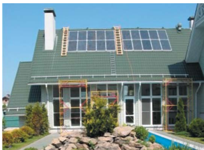
Солнечная электростанция: мощность солнечных батарей 3 кВт, инвертора — 13 кВА. Смонтирована в июне 2007 г. в Казани. Изготовитель ООО «ДЦА».
