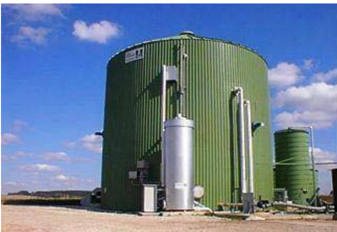
Метантенк — установка для переработки навоза в биогаз, Украина.
