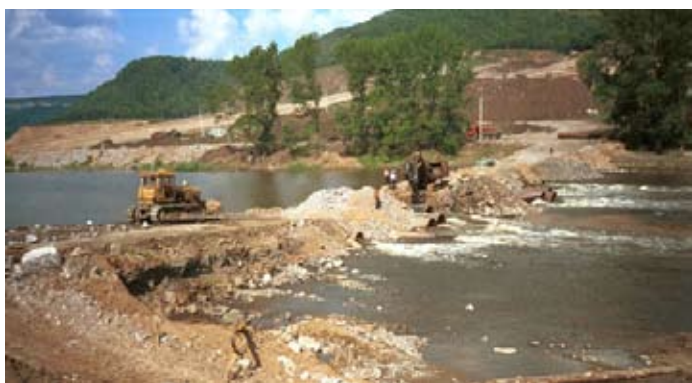
Строительство Юмагузинского водохранилища в национальном парке «Башкирия».
